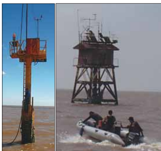
Figura 2. Pilote Norden (izquierda) y Torre Oyarvide (derecha) durante la instalación de los equipos.
